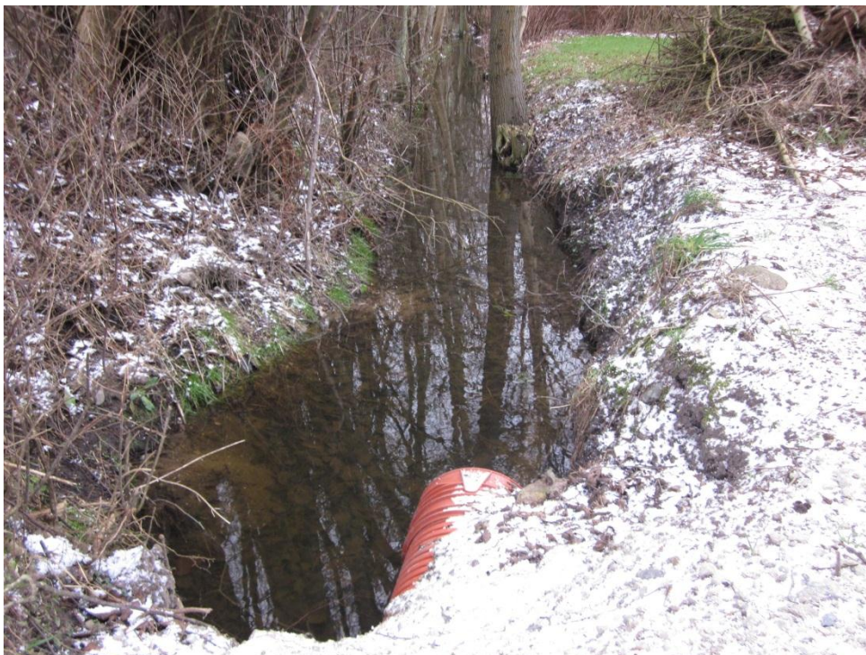
Figur 2: Underføring af åben grøft under Greigavej
