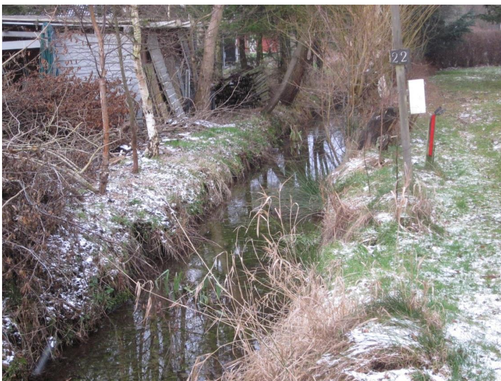
Figur 6: Åben grøft ved Golfvej, vist som rørlagt strækning på netkort.odsherred.dk
