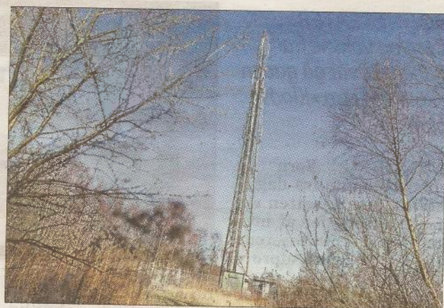
Mobildækningen i Odsherred er blevet bedre, efter at TDC har udskiftet og opgraderet en stribe antenner.
